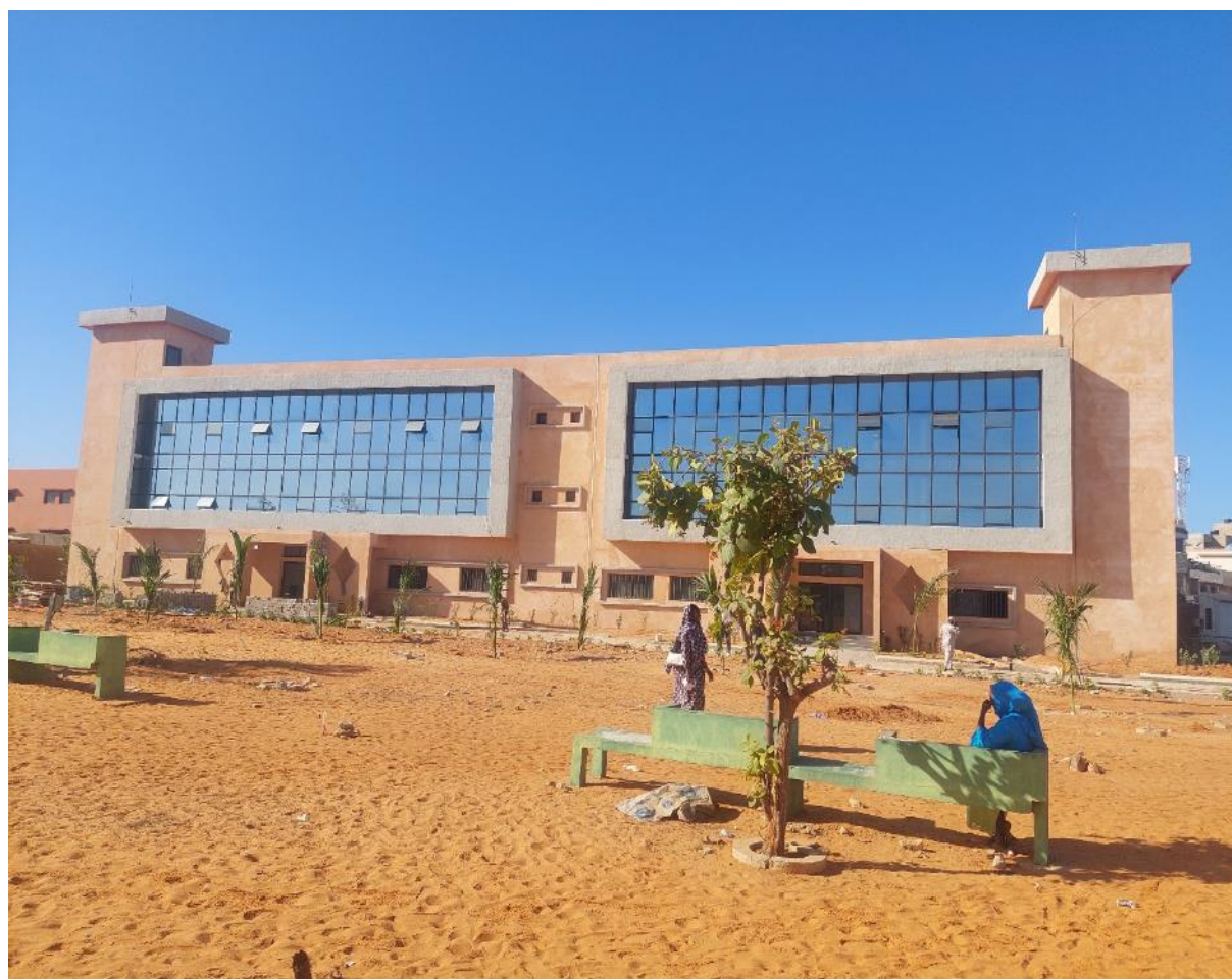
Image 2 : Présentation de l'ouvrage
