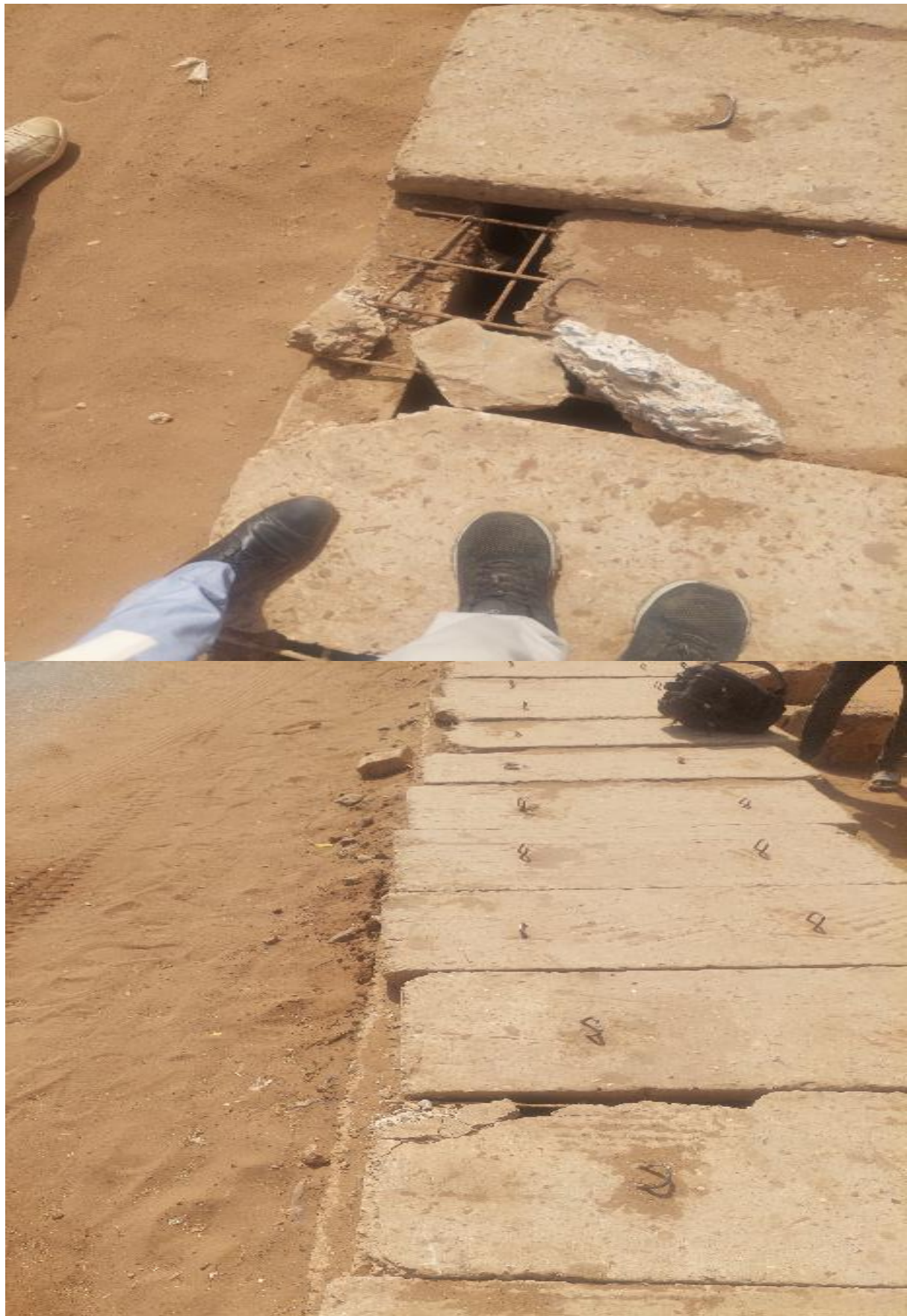
Image 4 : Différence de dimensions des dalles
