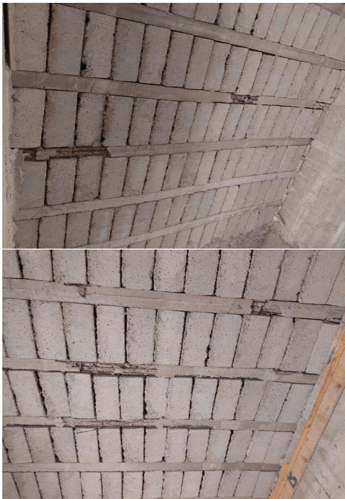
Image 2 : Apparition d'armatures sur certains éléments
