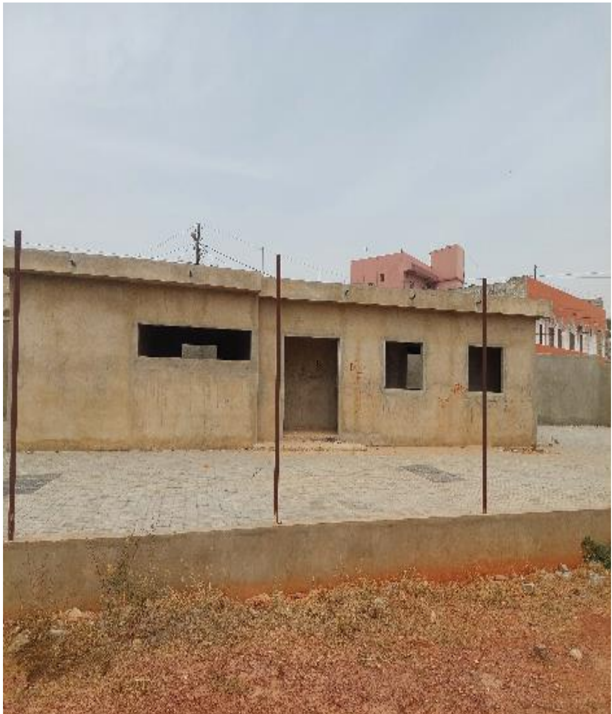
Image 5 : Vue d'ensemble du bâtiment administratif
