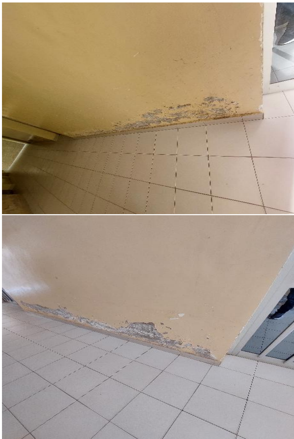
Image 7 : Remontée capillaire
