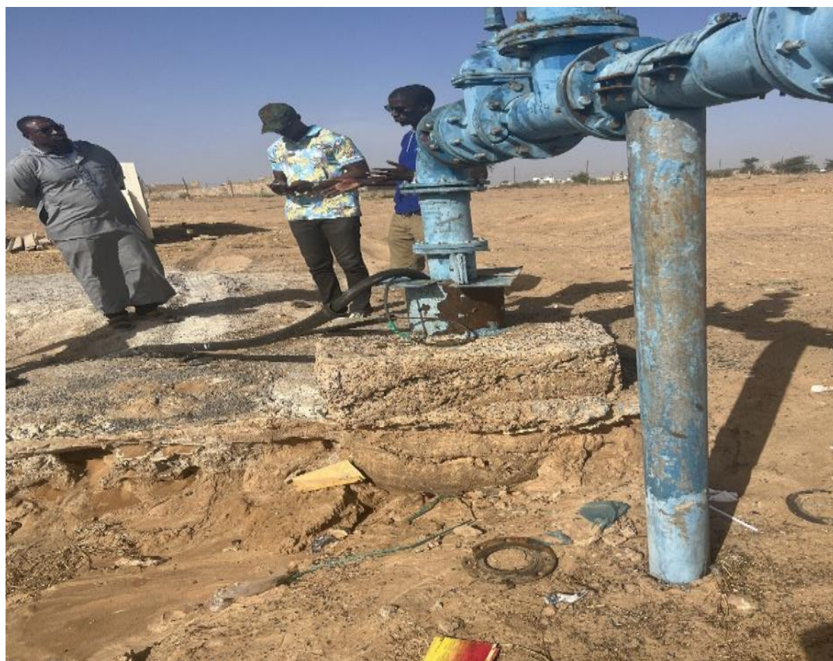
Image 1 : Vue d'ensemble du forage
