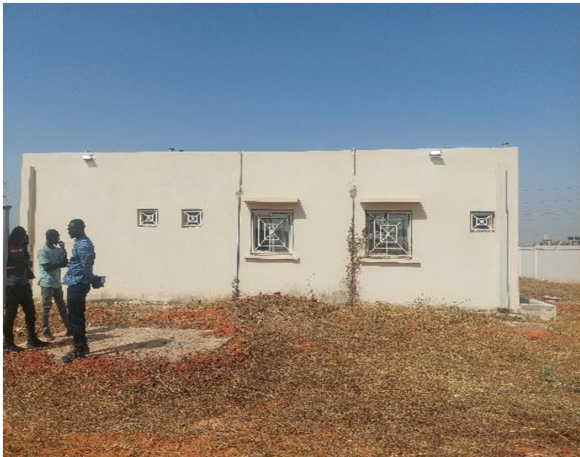
Image 2 : Présentation de la villa d'astreinte centrale solaire de Diass
