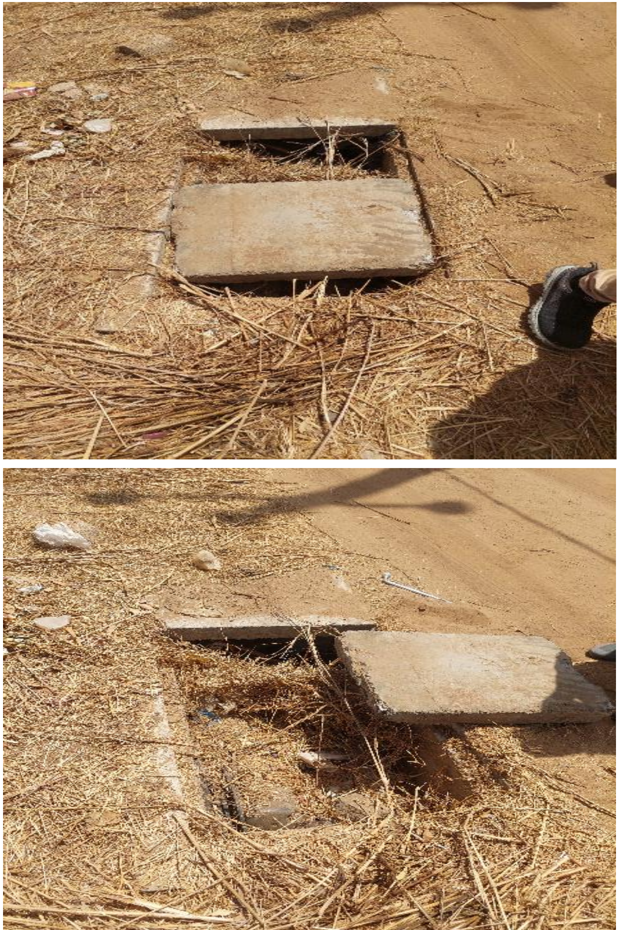
Image 8 : Réalisation d'une couverture avec une dalle manquante au village de Lam lalane
