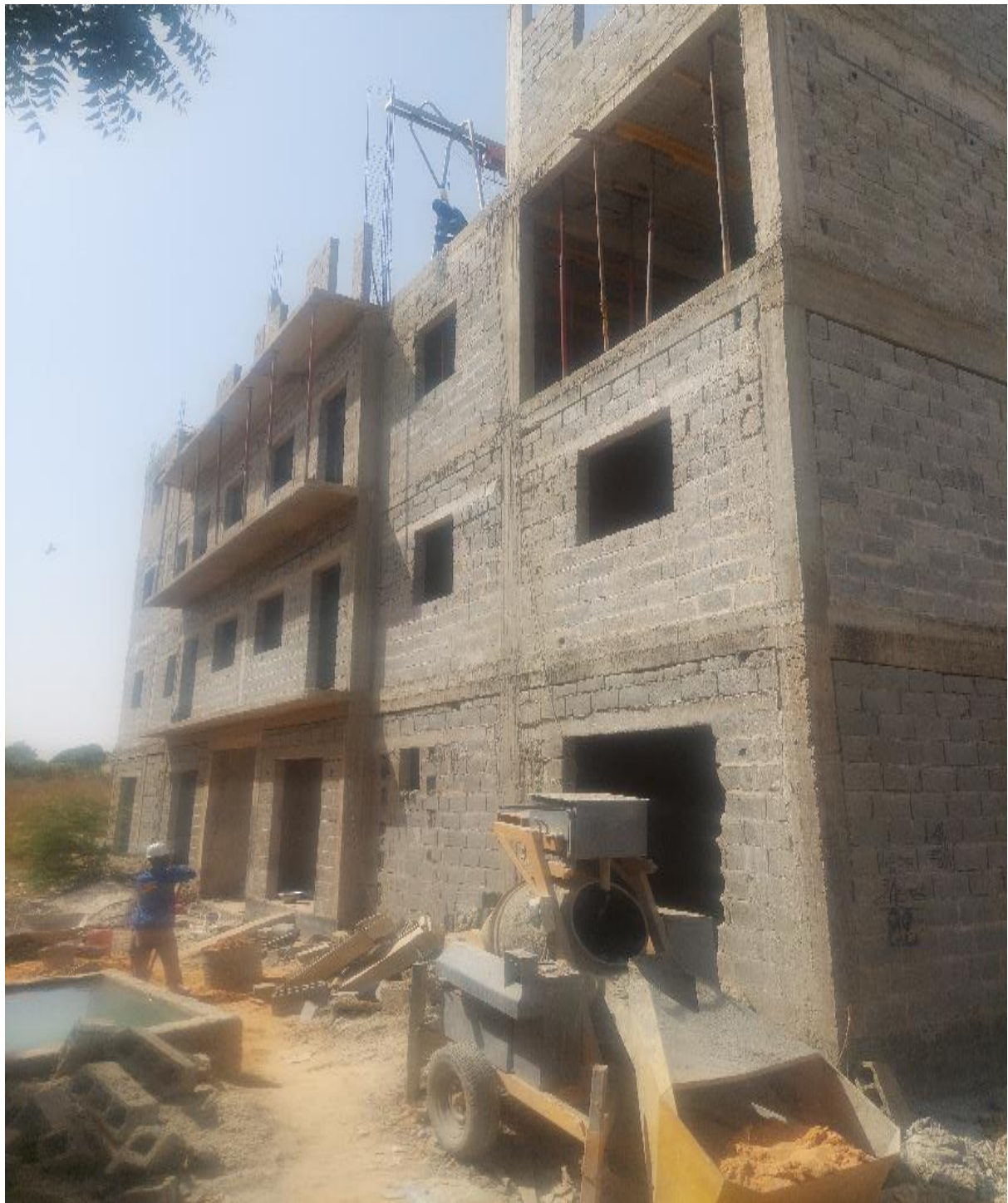
Image 2 : Présentation de l'ouvrage
