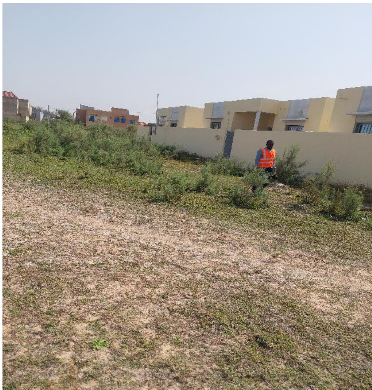
Image 8 : Anomalie sur le terrassement
