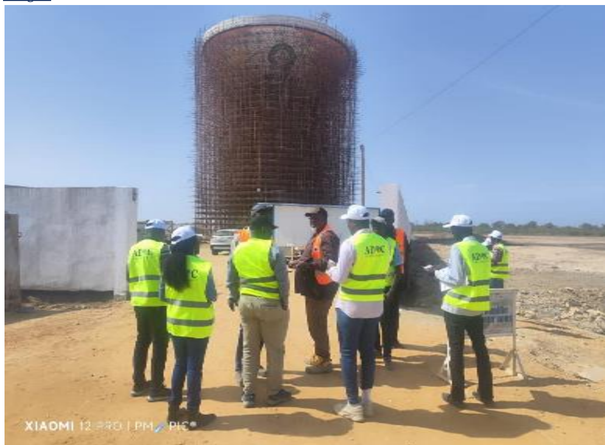
Image 4 : Présentation des travaux du château d'eau
