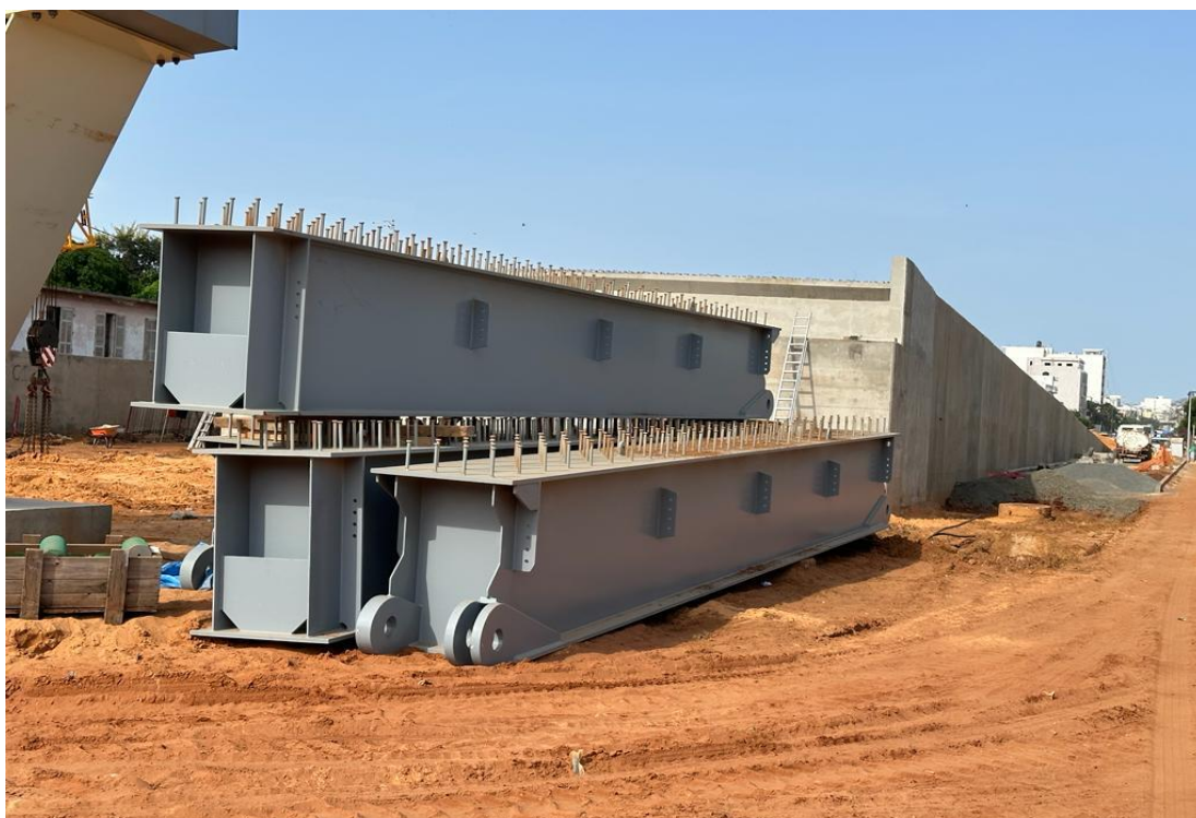
AUTO PONT DU FRONT DE TERRE : Travaux en cours
