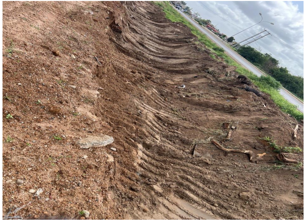
Drainage de l'eau de pluie
