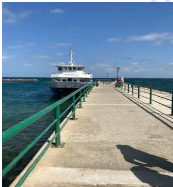
Aménagement du Quai : Marché Réhabilitation Embarcadère Ile de Gorée
