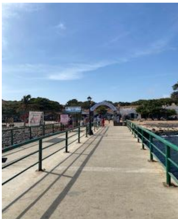
Construction de Défenses
