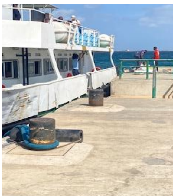
Installations de Bollards d'amarrage Réhabilitation Embarcadère Ile de Gorée.
