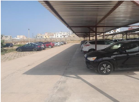
Marché Construction de Parkings intérieurs au CHNDJ
