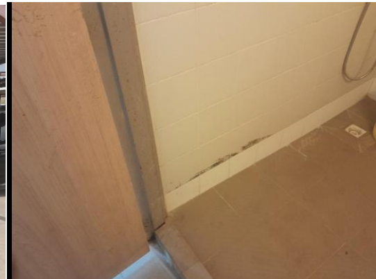
Marché : Travaux d'aménagement de bureau et de salles d'hospitalisation
