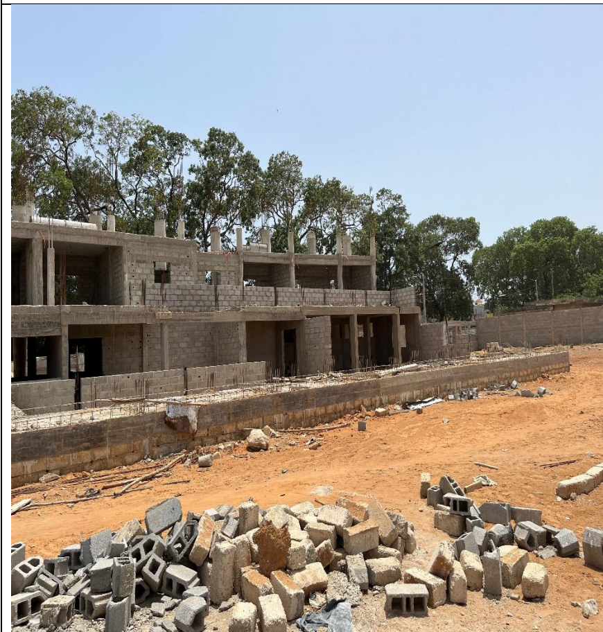
Travaux de construction des tribunes du stade en cours d'exécution
