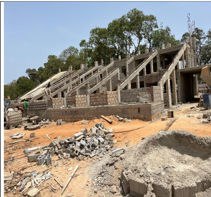
Travaux de construction des tribunes du stade en cours d'exécution
