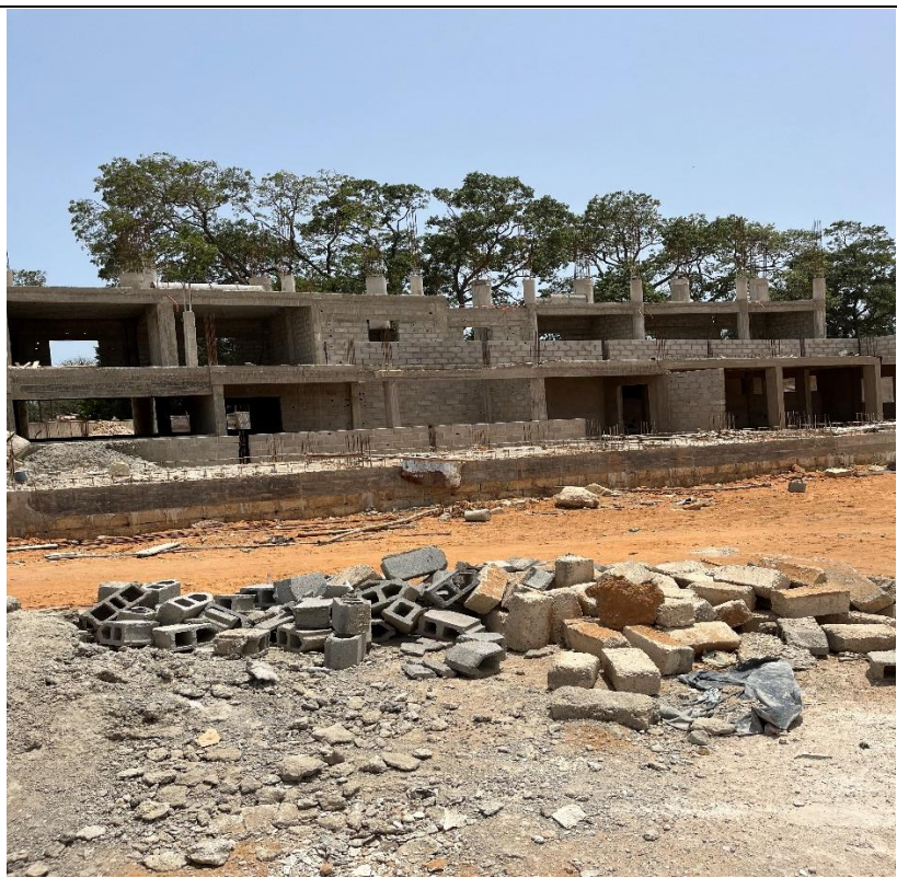
Travaux de construction des tribunes du stade en cours d'exécution
