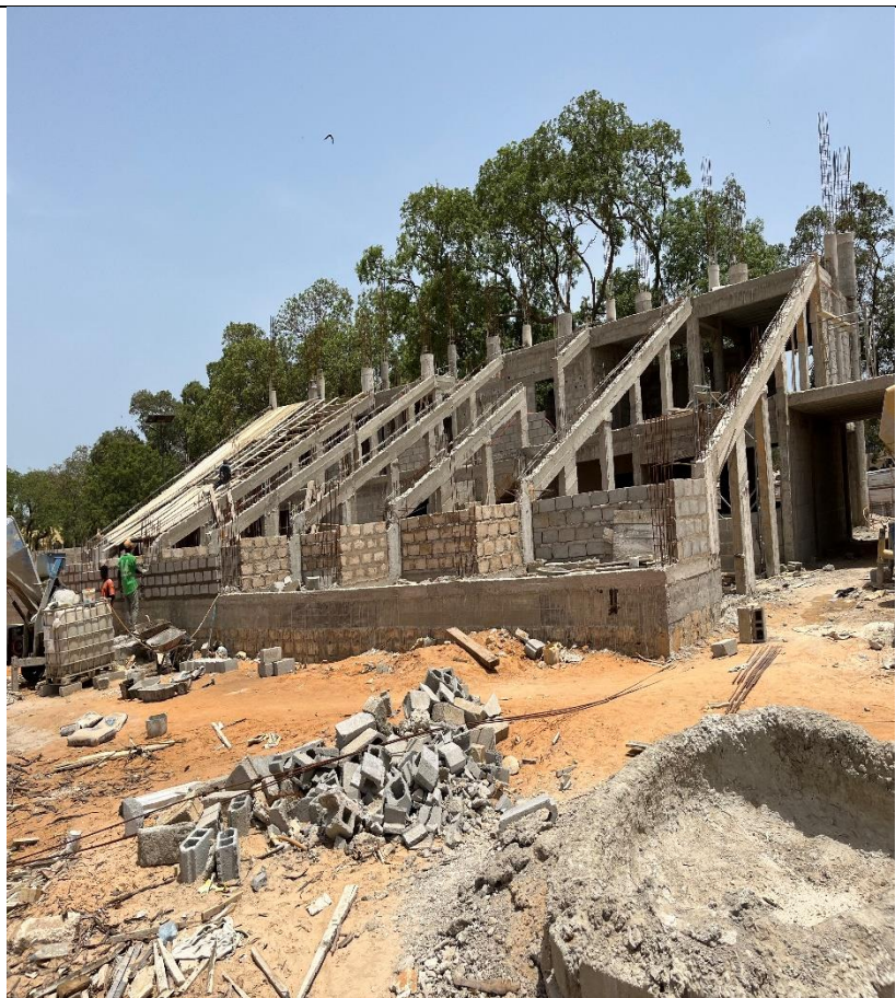
Travaux de construction des tribunes du stade en cours d'exécution
