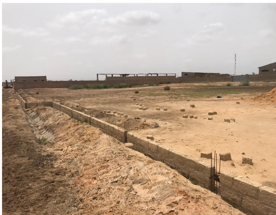
Murs de la fondation de l'unité de production.
