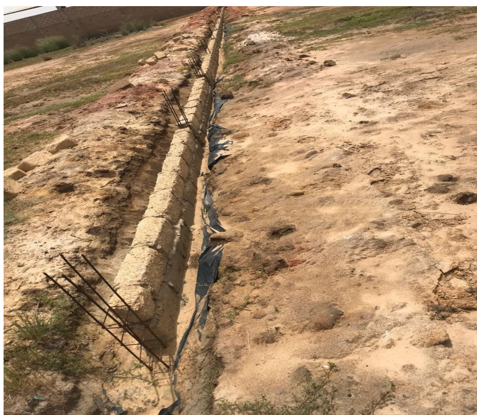
Les fondations du mur de l'unité de production.
