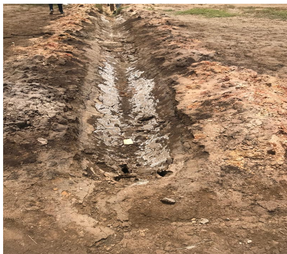
Tranché destinée à recevoir les fondations.
