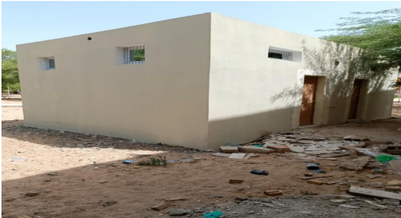
Réhabilitation du bloc toilette du bâtiment G.
