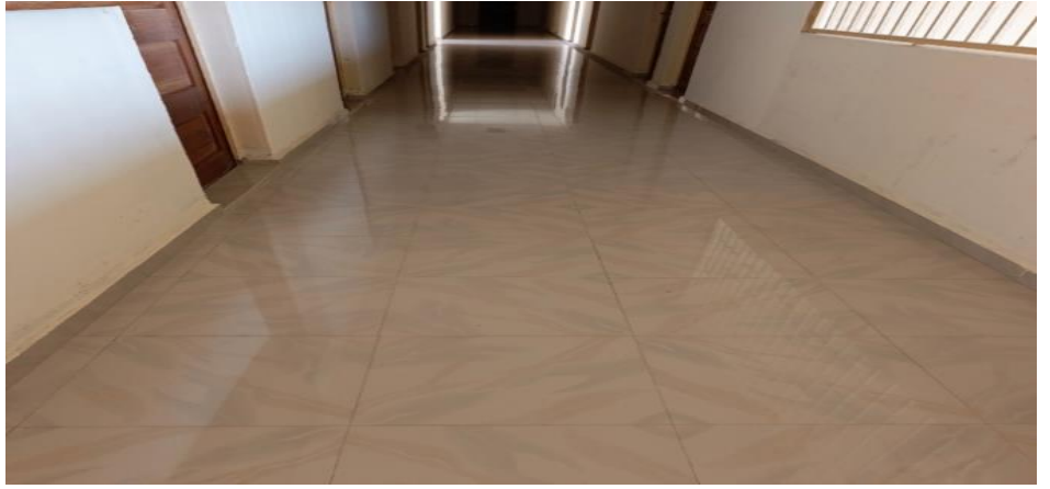
Réhabilitation et carrelage du bâtiment DMT du rectorat.
