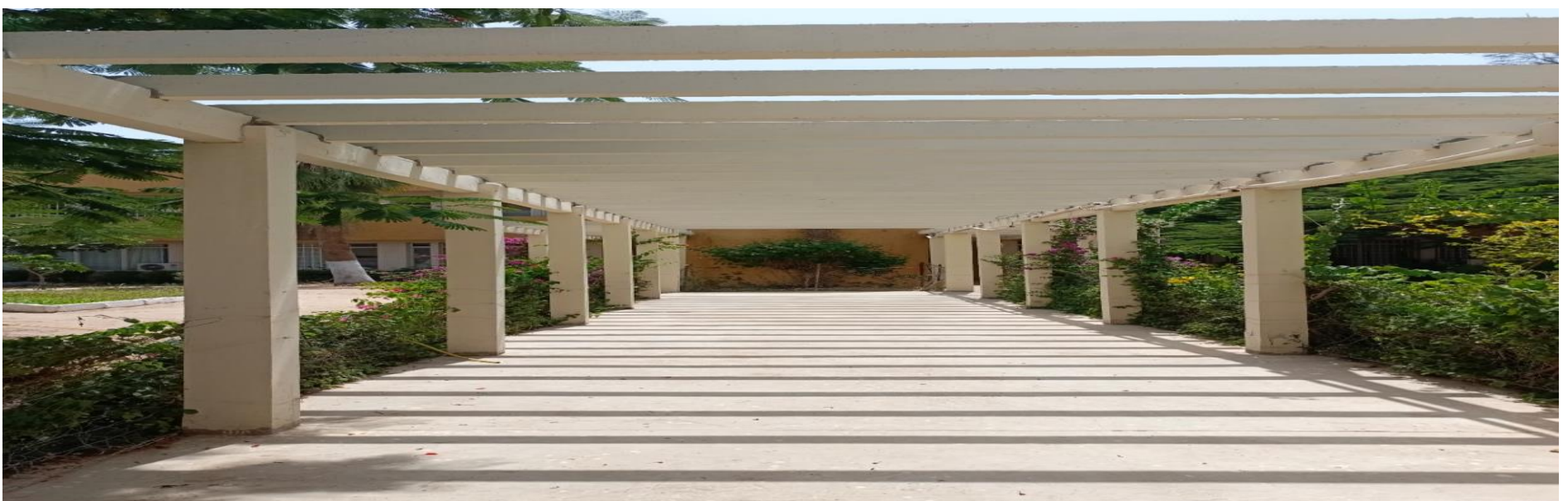
Réhabilitation et de l'allée du bâtiment DMT du rectorat.
