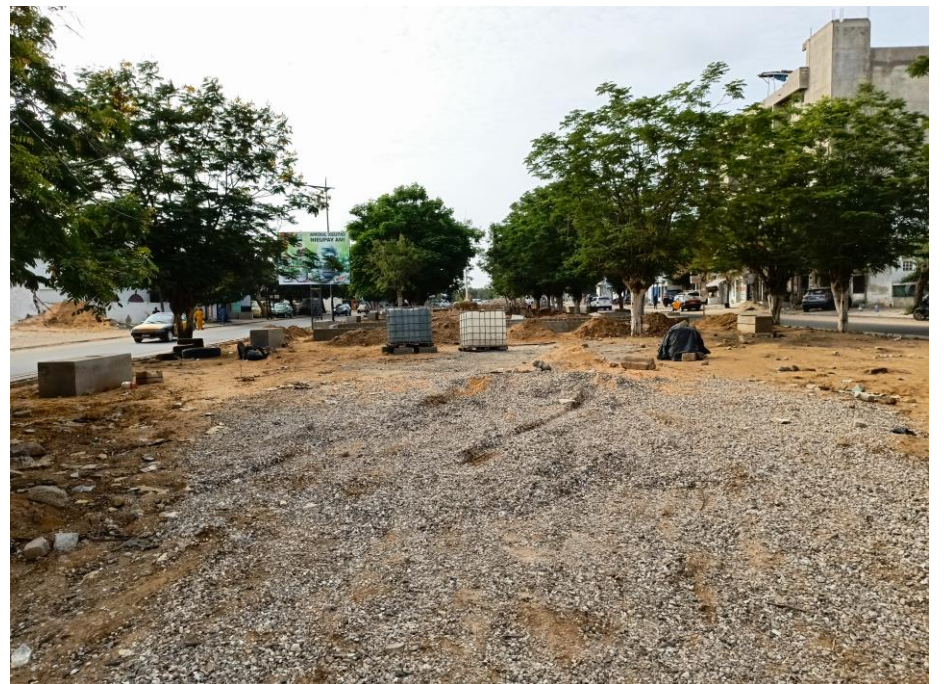
Les travaux des espaces d'expression artistique, des aires de jeux pour enfants, des espaces piétonnes, en cours de réalisation.
