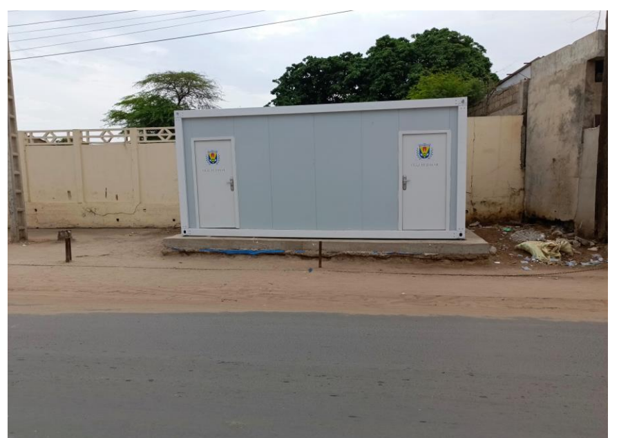
Certaines toilettes ne possèdent pas les rampes pour faciliter l'entrée des personnes à mobilité réduite, ce qui est contraire aux spécifications mentionnées dans le DAO.
