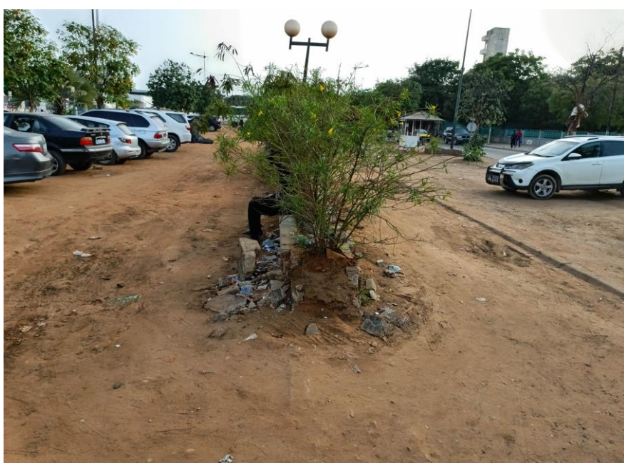
Les travaux des parkings et plusieurs esplanades multifonctionnelles qui n'ont pas encore démarré.
