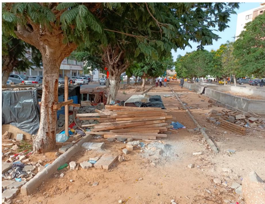
Les travaux des espaces d'expression artistique, des aires de jeux pour enfants, des espaces piétonnes, en cours de réalisation.
