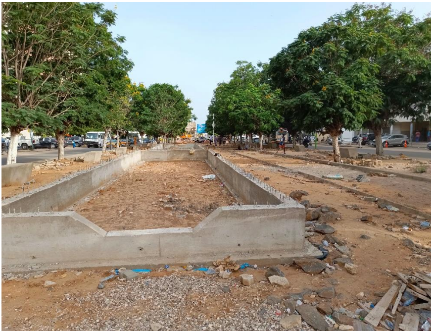
La mission a constaté un retard des Travaux des espaces sportifs, notamment de fitness et de musculation sont en cours de réalisation.
