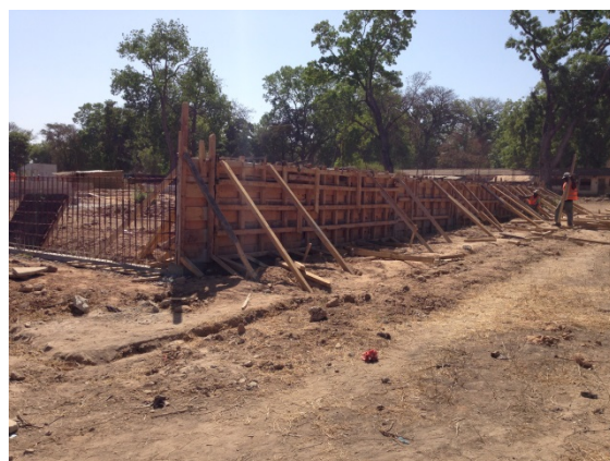
Ferrailage voile en béton en cours
