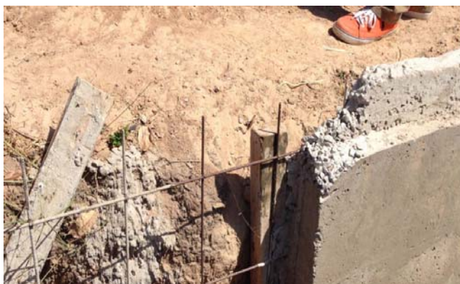
Ferrailage insuffisant au niveau couronnement en béton armé
