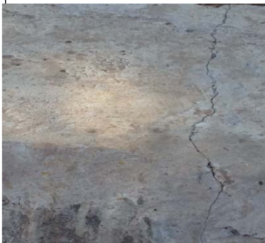
Fissuration transversale au niveau caniveau : absence de joint dans tout l'ouvrage
