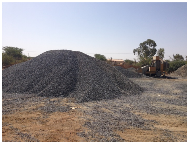
Granulats de basalte utilisé pour le béton en lieu et place des concrétions préconisées par les prescriptions techniques
