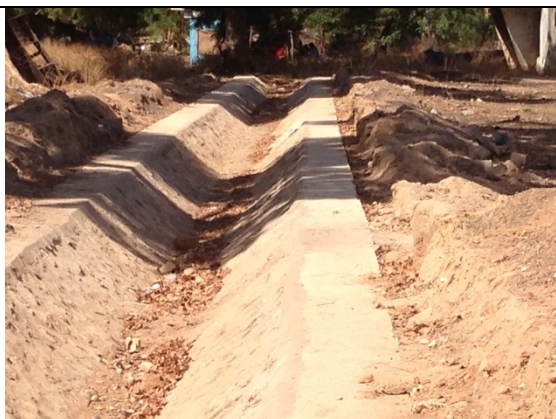
Caniveau trapézoïdal en perré maçonné
