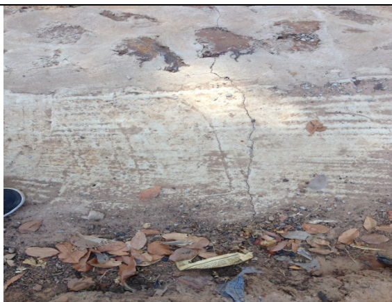
Fissures transversales au niveau caniveau : absence de joint dans tout l'ouvrage
