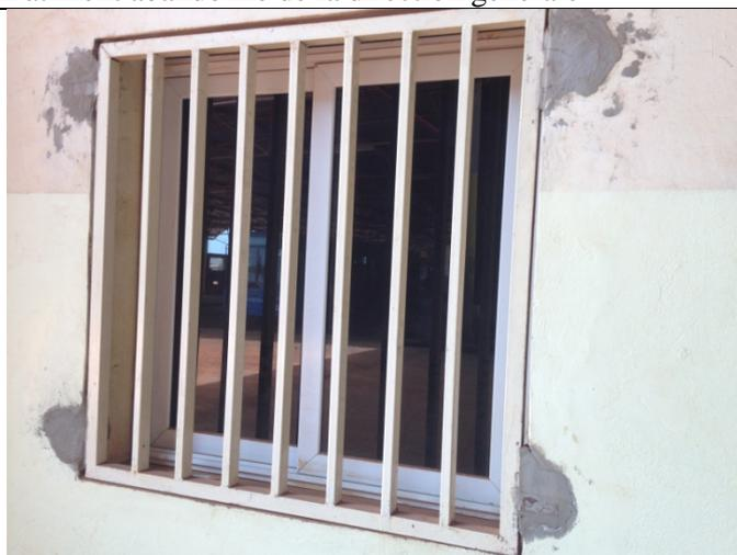
Travaux de raccordement peu soignés et non-conforme aux règles de l'art des grilles
