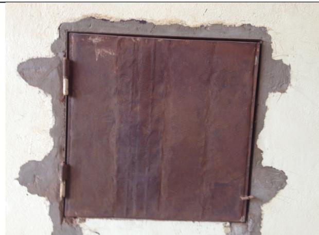
Travaux de raccordement peu soignés de fenêtre non prévu par le contrat.
